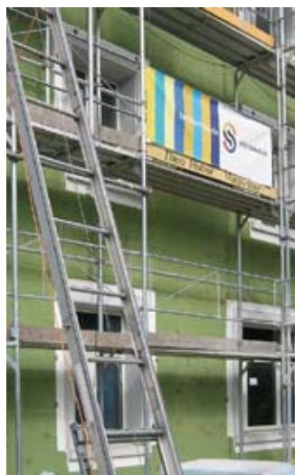
Fassadendämmung mit Mineralwollplatten
